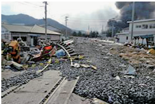
南リアス線の被災状況（盛～陸前赤崎間）
