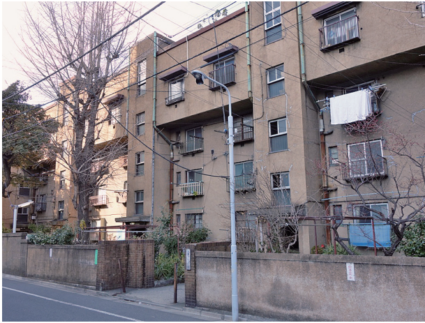
同潤会・上野下アパート（1929年（昭和4年）竣工、RC造2棟4階建・総戸数76戸、1～3階家族向け、4階独身者向け）。16ヶ所建設されたうち唯一現存、他は解体・建替え。JR上野駅から徒歩圏内。戦後の団地から現在のマンションに至る集合住宅の原点的な存在。2013年5月解体・建替えの予定。 資料：（株）日本経済研究所作成
